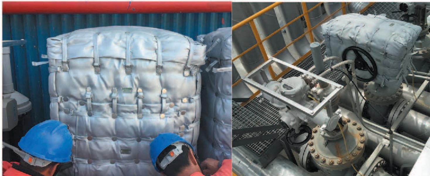
肯普尼特柔性防火罩采用预成型填充物制成，安装在被保护系统的四周，通过扣带方式连接在一起。
