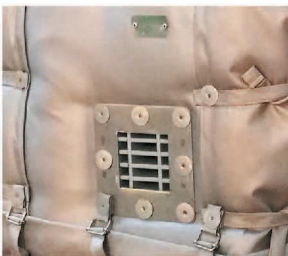
**通风格栅：**通风格栅内部预填充防火膨胀材料，当发生火灾时，温度达到100°C，通风格栅内部会自动膨胀，阻止火焰进入防火罩。
