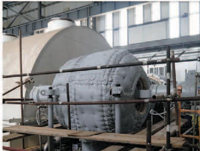
柔性隔热罩，易于安装和拆卸，尤其适用于频繁检修和维护的工厂。
